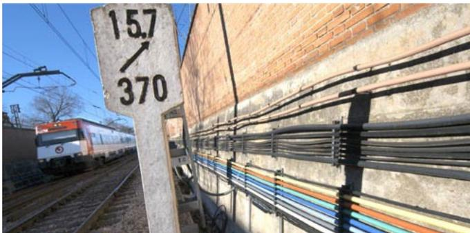
La red de cableado recorre muchos de los caminos que hacemos a diario aprovechando otras infraestructuras. La fotografía muestra una instalación de cableado de fibra óptica junto a las vías de tren de Cercanías.
